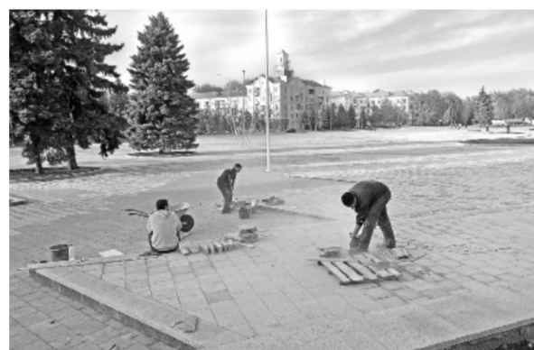
Главную площадь Краматорска почти полностью замостили новой плиткой
